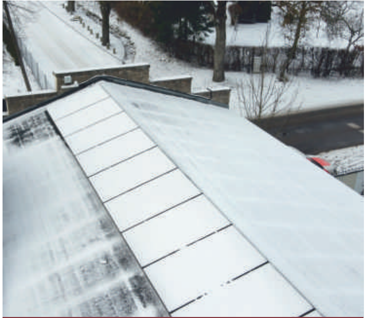
Świetlica w Tarnowie
