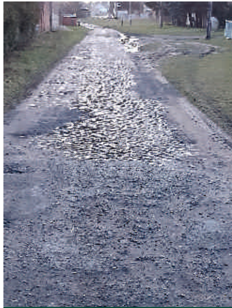
Droga w Żukowie przed przebudową
