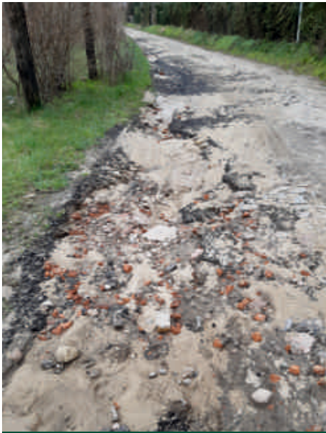
Droga w Żukowie przed przebudową
