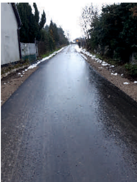
Droga w Żukowie po przebudowie
