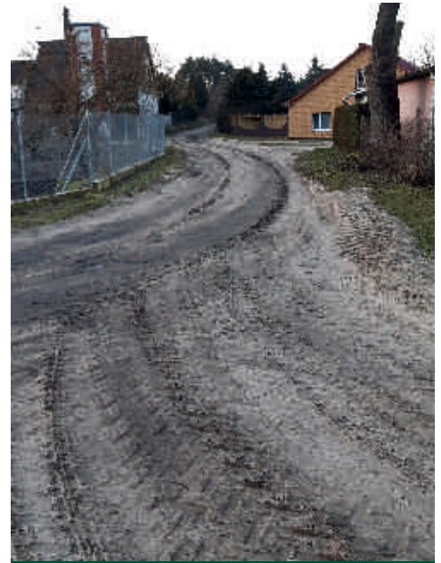
Droga w Żukowie przed przebudową
