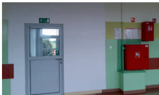
Modernizacja ppoż. klatek schodowych
