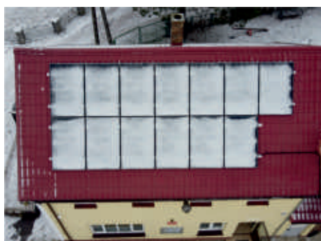
Instalacja fotowoltaiczna w świetlicy w Żukowie
