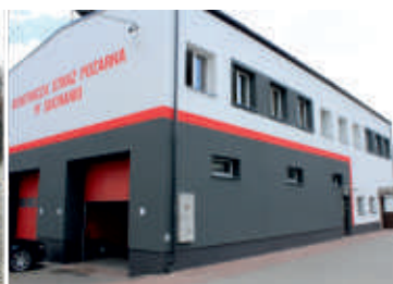
Termomodernizacja remizy Suchaniu
