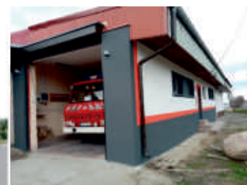
Termomodernizacja remizy w Wapnicy
