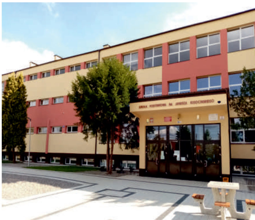
Termomodernizacja budynku szkoły
